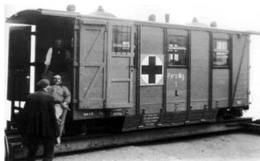
Der kombinierte Sanitäts- und Personenwagen, unten mit aufgeklappter Stirnwand.
